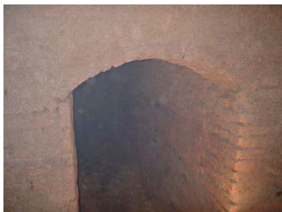
Fig. 132 – Cunicolo che collega locali di cisterna sotto un edificio di via Volta (foto Studio Tecnico Pizzi e Impresa Palmulli Giuseppe).
