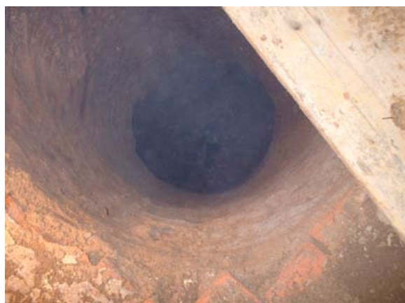
Fig. 131 – Pozzo di ispezione che adduce alla cisterna sotto un edificio di via Volta (foto Studio Tecnico Pizzi e Impresa Palmulli Giuseppe). 584
